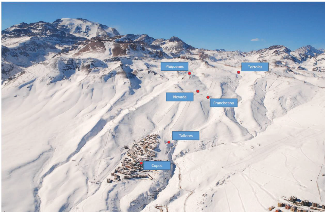
Imagen N° 3: Ubicación de estanques de combustible
