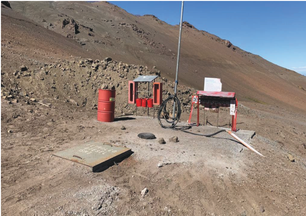
Imagen N° 7: Situación Estanque Tórtolas actual (enterrado)
