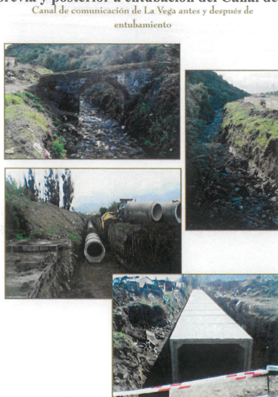
Figura 5: Comparación previa y posterior a entubación del Canal de comunicación de la Vega
