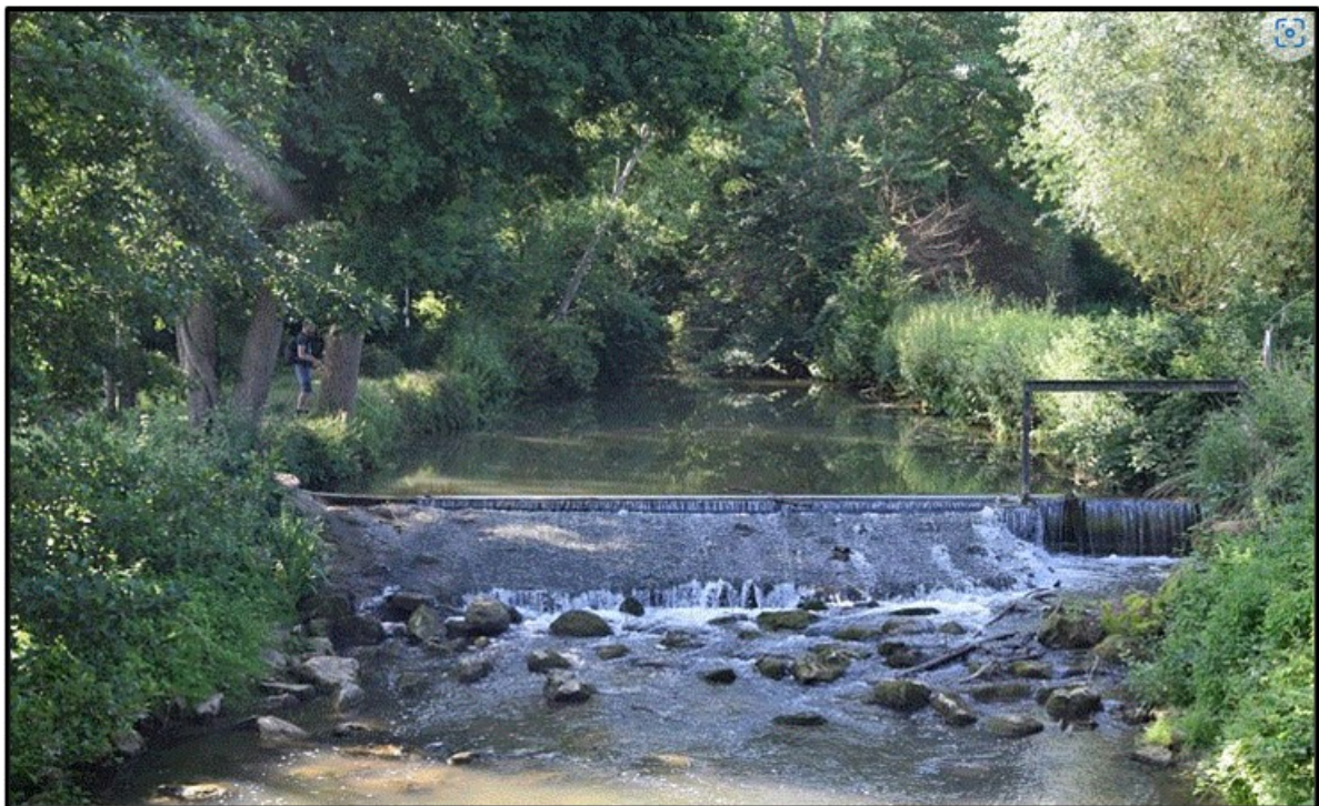
Ilustración 3 Fotografía de un azud instalado en un río (referencial)
