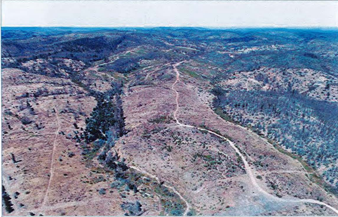
Figura 23: En primer plano plantaciones quemadas y posteriormente aprovechadas. En la actualidad con regeneración vegetativa de aproximadamente 3 metros, con 3 a 4 retoños por tocón. Lo anterior permite apreciar la inserción de quebradas con matorral y bosque nativo.
