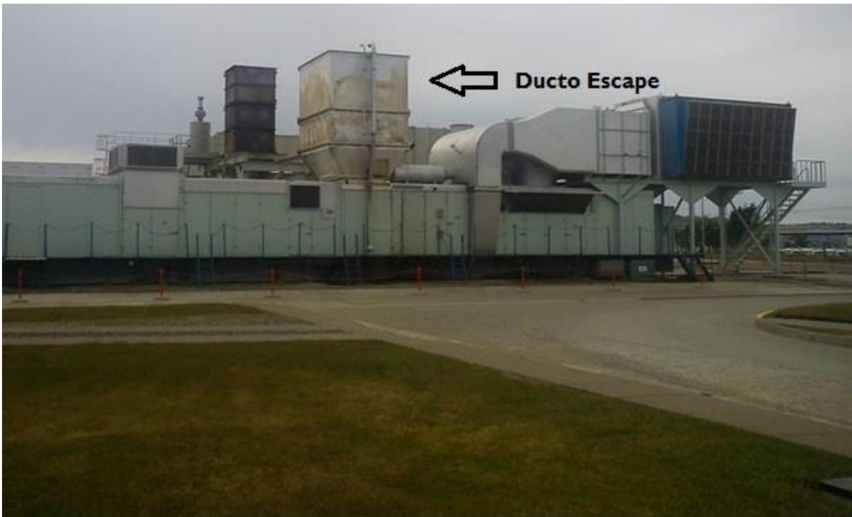
Figura 5: Ducto de escape de gases de combustión.
