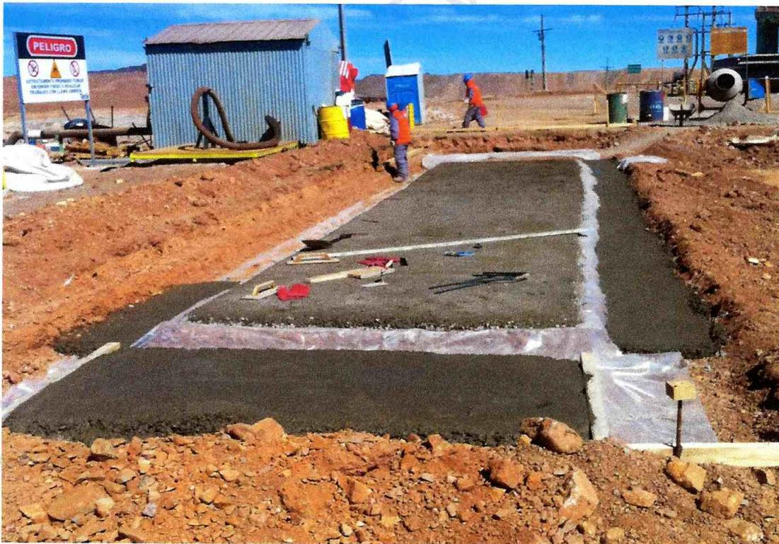
**Imagen 1.**-Avance en proceso de construcción de losa para la descarga de camiones.
