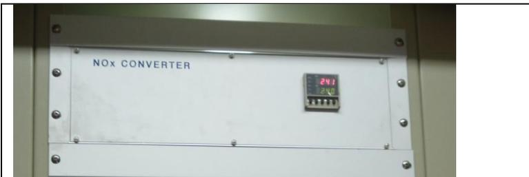
Fig. 5: Convertidor NO<sub>x</sub> con setpoint temperatura en 240°C
