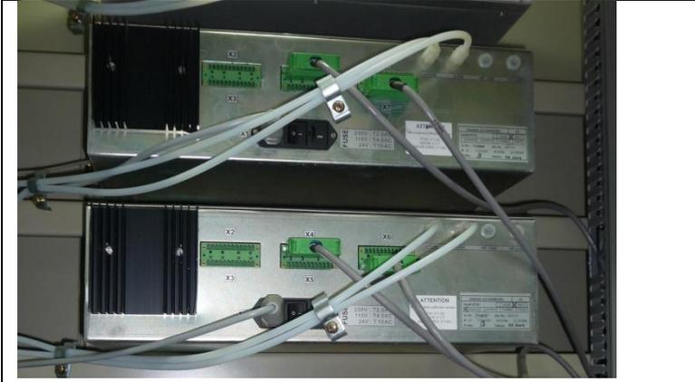
Fig. 4: Salidas X5 y X6 para válvulas sin conectar
