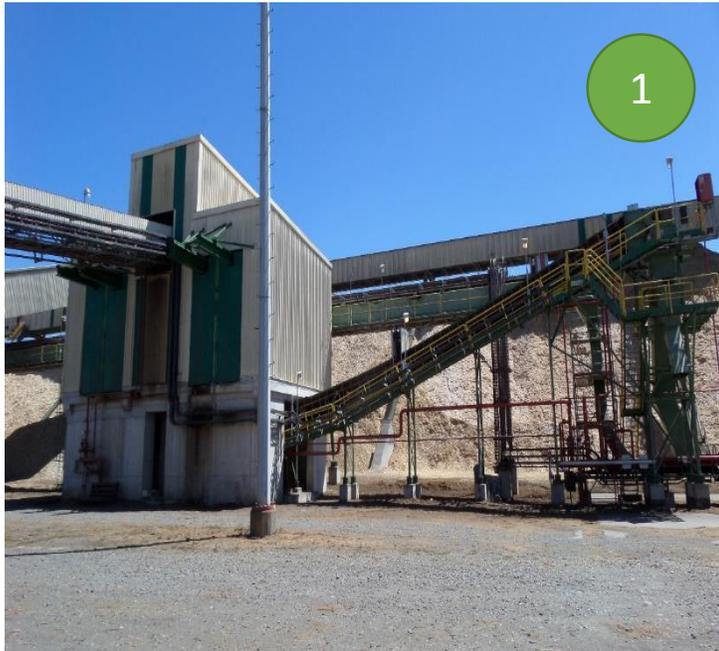
1.- Cierre de vanos Edificio Triturador Saalasti con paneles acústicos y revestimiento interno de material absorbente.
