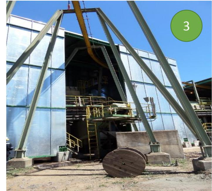
3.- Encierro de la Línea 2 de Proceso (Astillador y Descortezador) con paneles acústicos y revestimiento interno de material absorbente.
