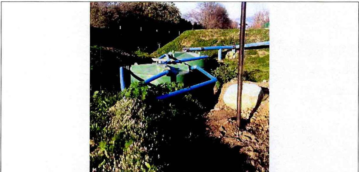
Fotografía N° 2: Tanque Clorador implementado durante el desarrollo del PDC
