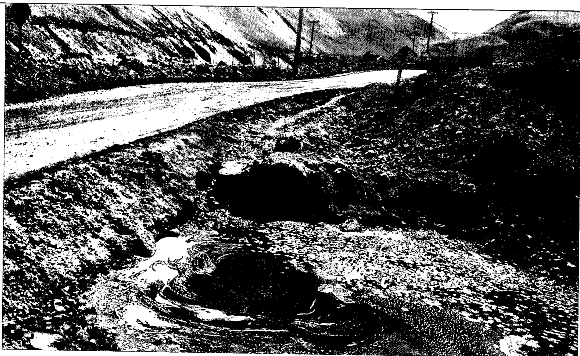
Foto N°2. Flujo de agua proveniente de la vega EY-1 y alcantarilla N°1, en el camino Público G-455.
