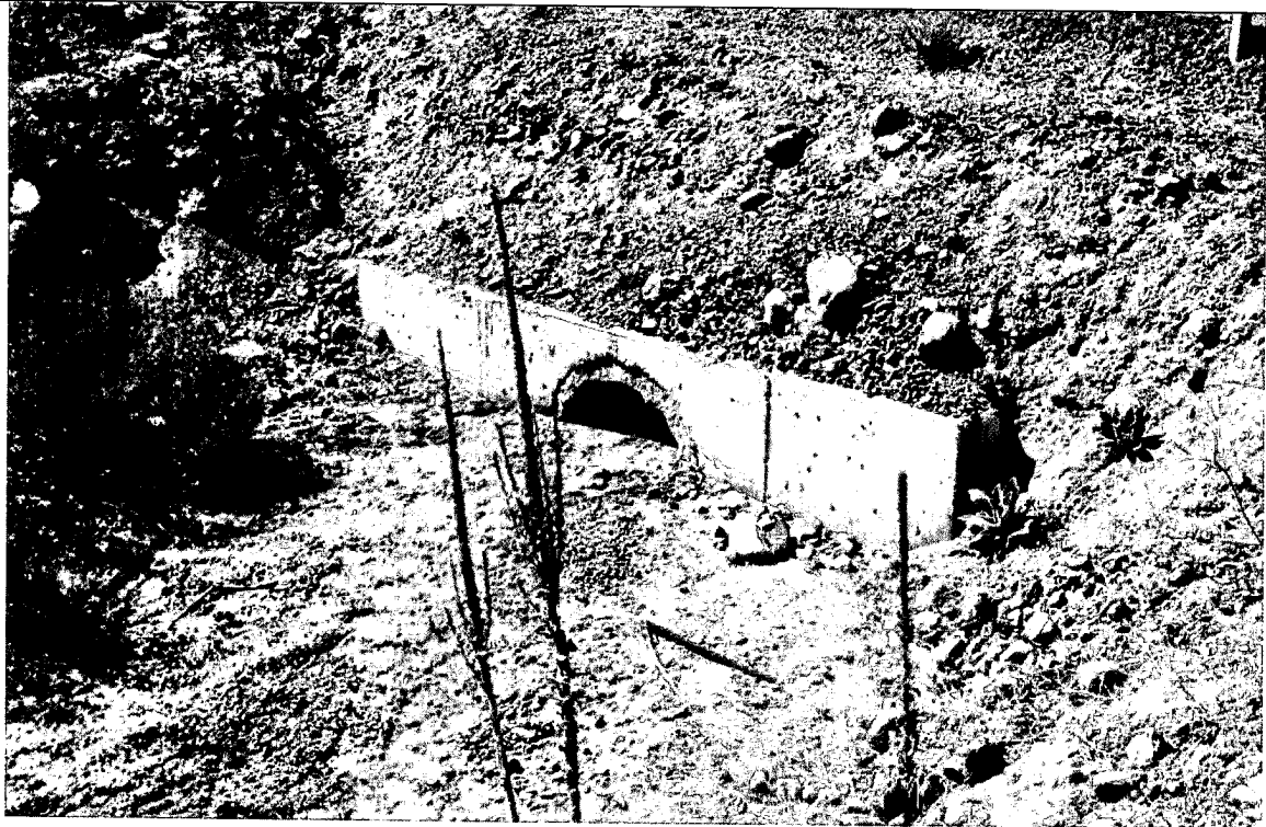
Foto N°5. Desagüe alcantarilla N°2.
