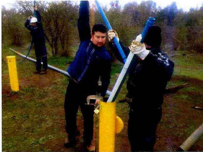
Fotografía N° 2. Retiro de tuberías de PVC
