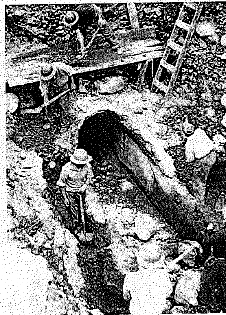
Figura 3. (Derecha) Daño en el canal del Maipo. (Izquierda) Daño en un acueducto del cajón del Maipo producto del terremoto de Las Melosas 1958. Figuras de los trabajos de Sepúlveda et al. (2008) y Alvarado et al. (2009).
