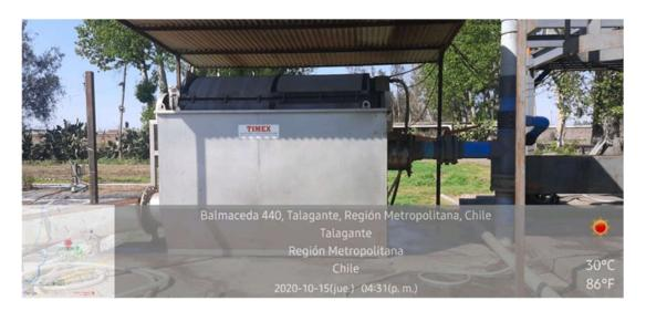
Reforzamiento del sistema de aireación mediante la instalación de un segundo soplador lobular, Marca Aerzen, de 600 m³/hora y una red de distribución y membranas de difusión sumergidas, el cual se instaló en el mes de junio de 2019
