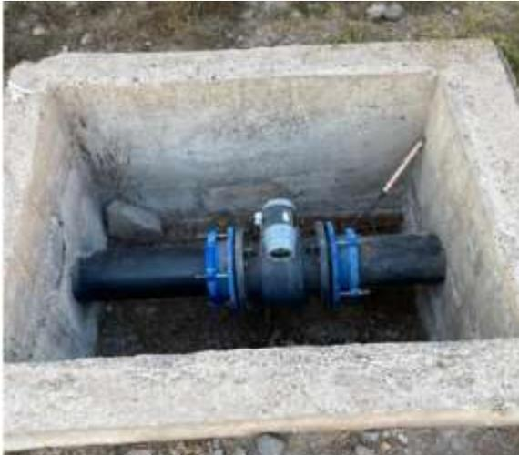
12 de Mayo de 2021: Verificación y medición de comparación en Flujometro Electromagnético
