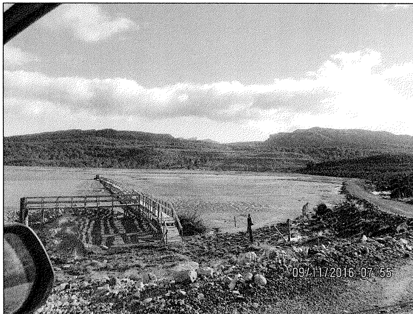
Foto 7. Vista hacia el norte. 9 de noviembre, 2016.
